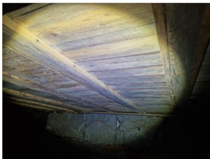
Torpargrund: Mikrobiell påväxt noterades på undersida bjälklag
