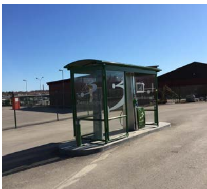
Station för biogas vid Drakvägen.
